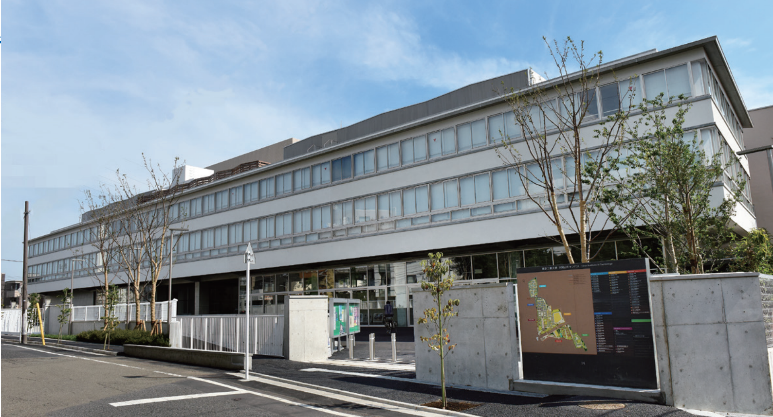
ELSI-1 棟の外観
